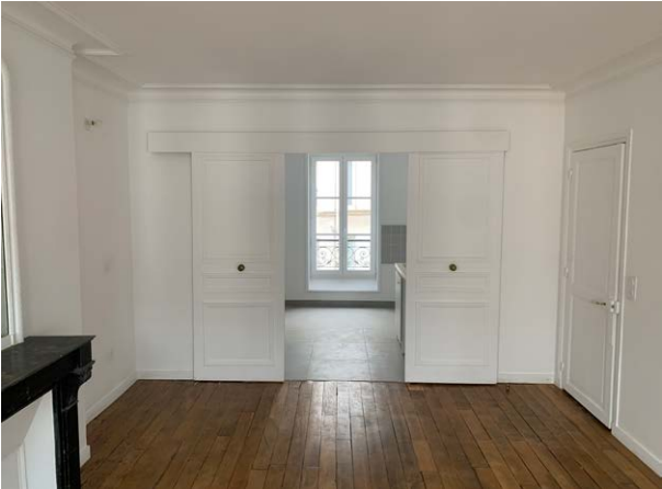
Réemploi des portes palières
